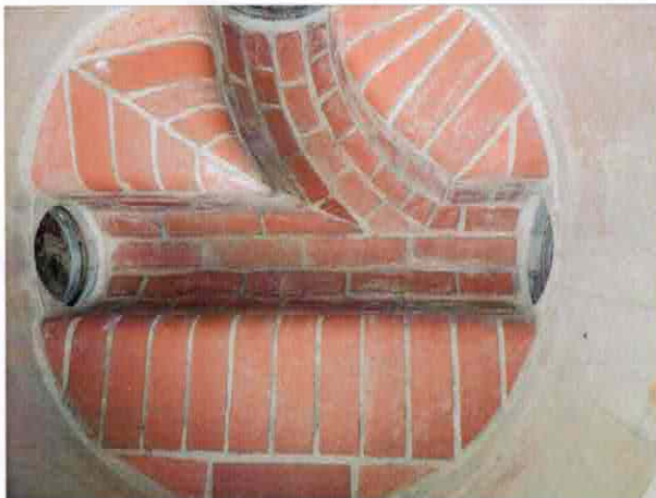
A: Ausführung des Schachtunterteils aus Mauerwerk mit drei Rohranschlüssen
